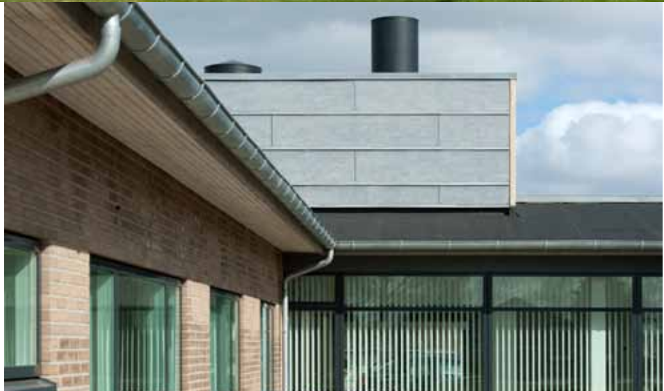
Kragelund Plejecenter, Silkeborg • Ældreboliger • Silkeborg Kommune
