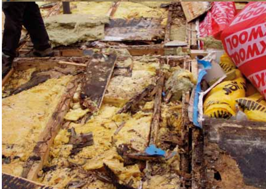
Udbedring af skader i tagkonstruktion med uventilerede tagkassetter
