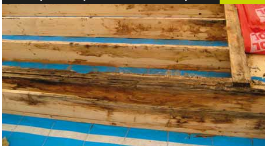
Udbedring af skader i tagkonstruktion med uventilerede tagkassetter
