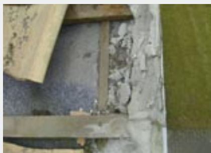
Murede gavle uden udhæng skal have bagmur
